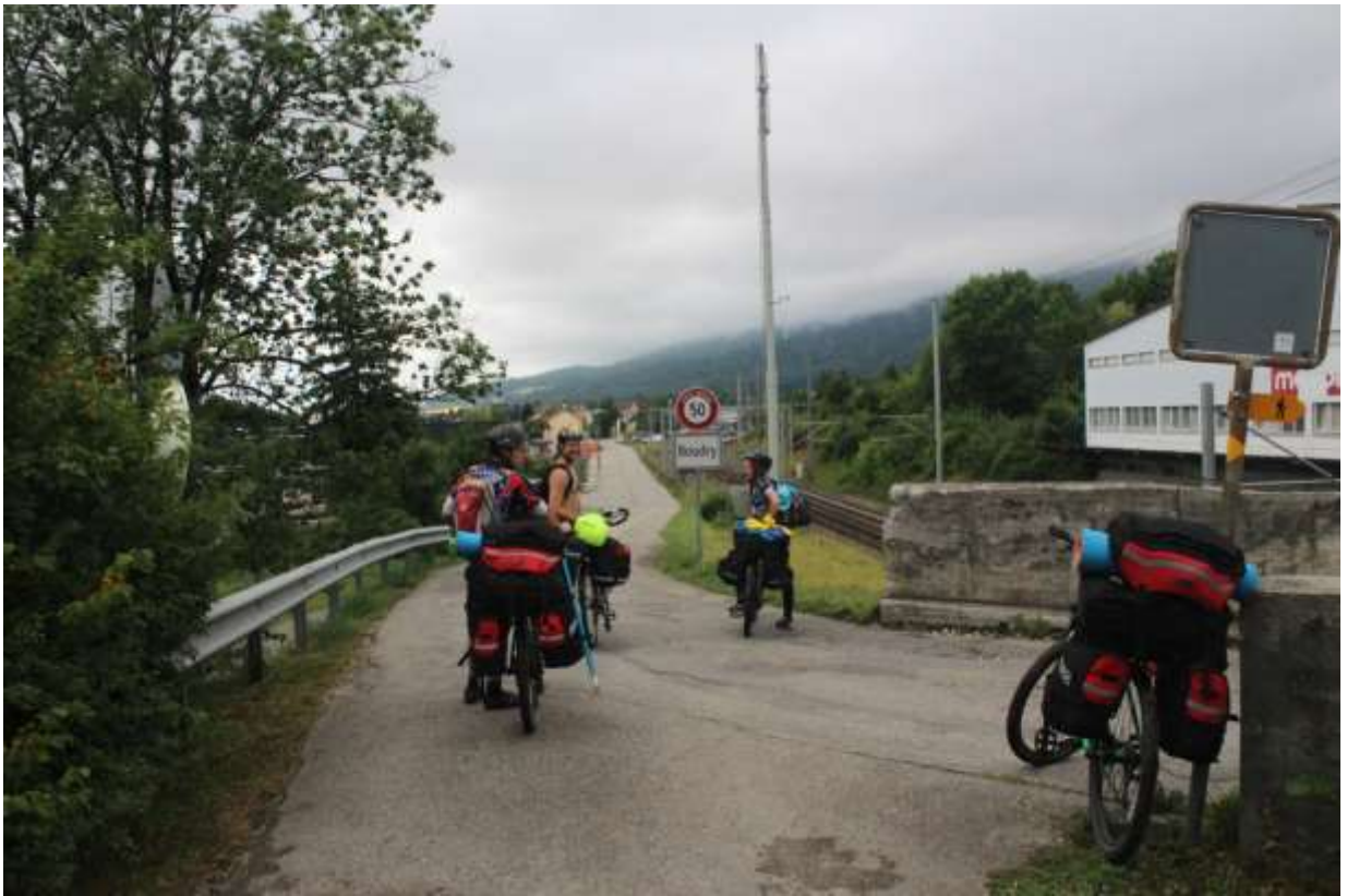
Фото 74. Бетонный мост через ж/д на въезде в город Boudry
