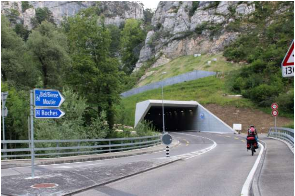
Фото 52. Въезд в тоннель длиной около 100 метров
