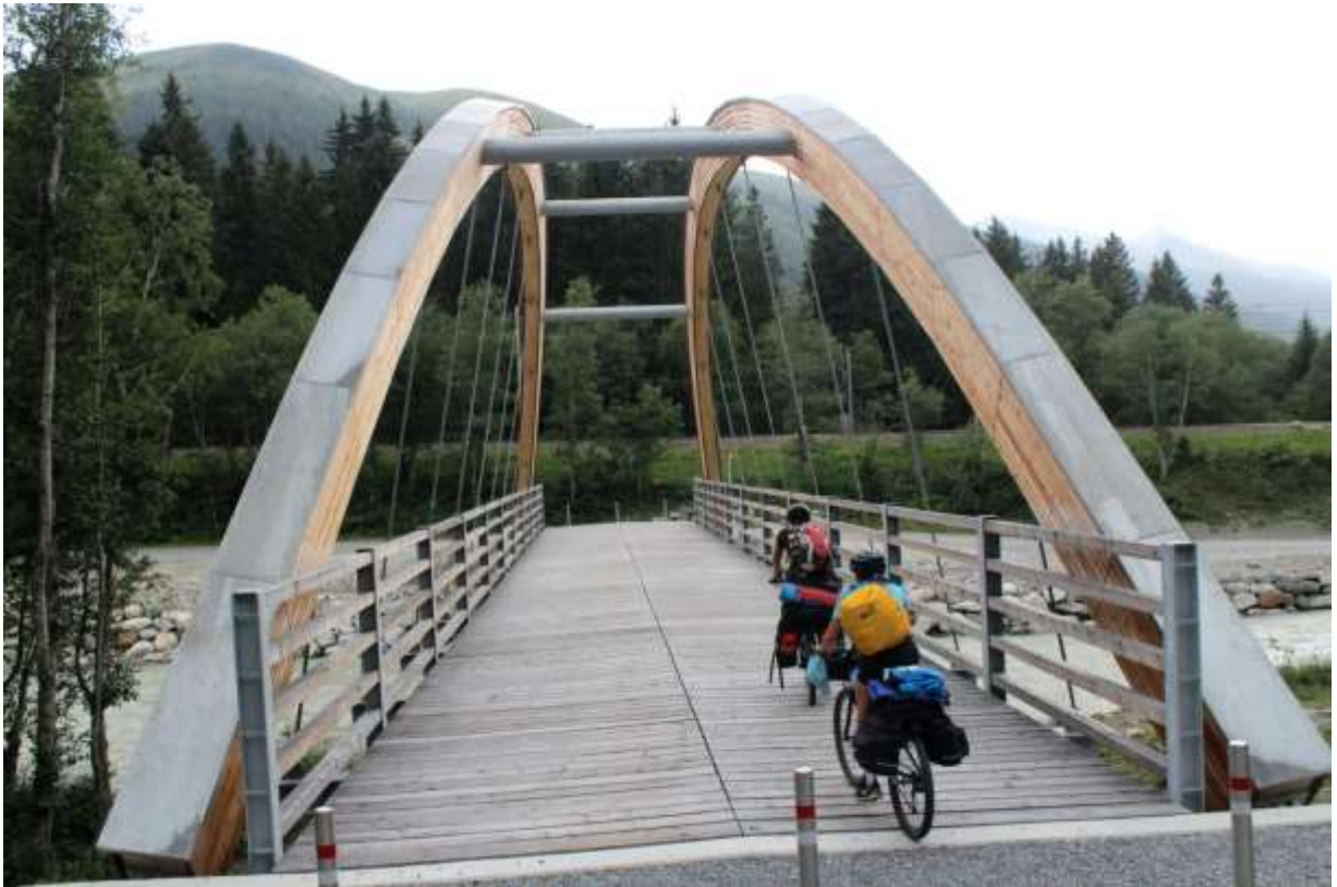
Фото 202. Пересекаем реку Rhone по деревянному мостику.
