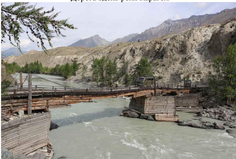
Мост через реку Аргут
