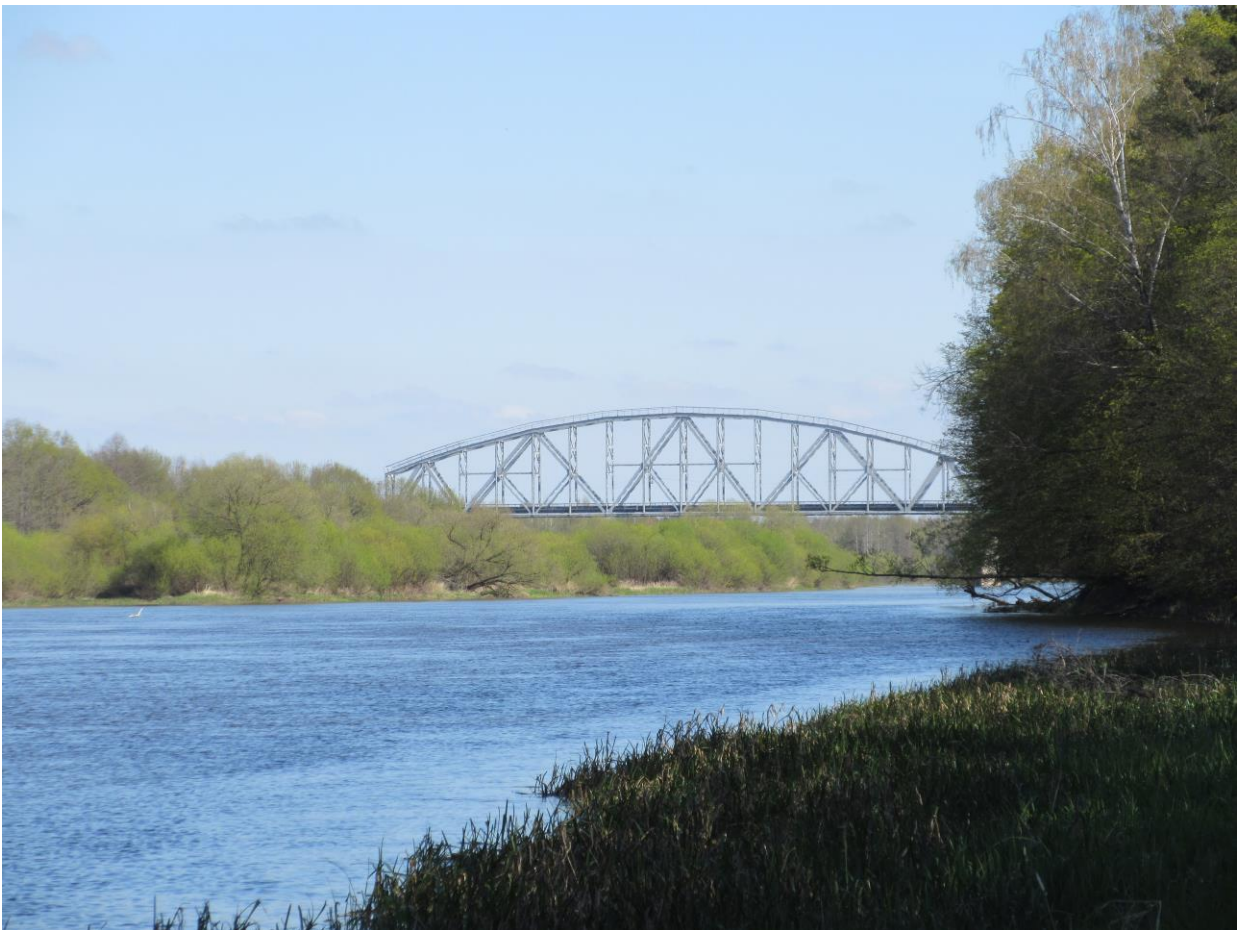
Железнодорожный мост через Березину, расположенный южнее а.г. Елизово
