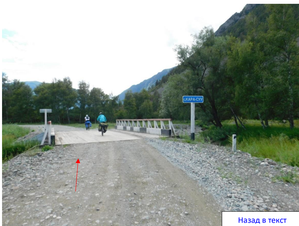
Фото 12. Проезд через мост через р. Кара-Суу
