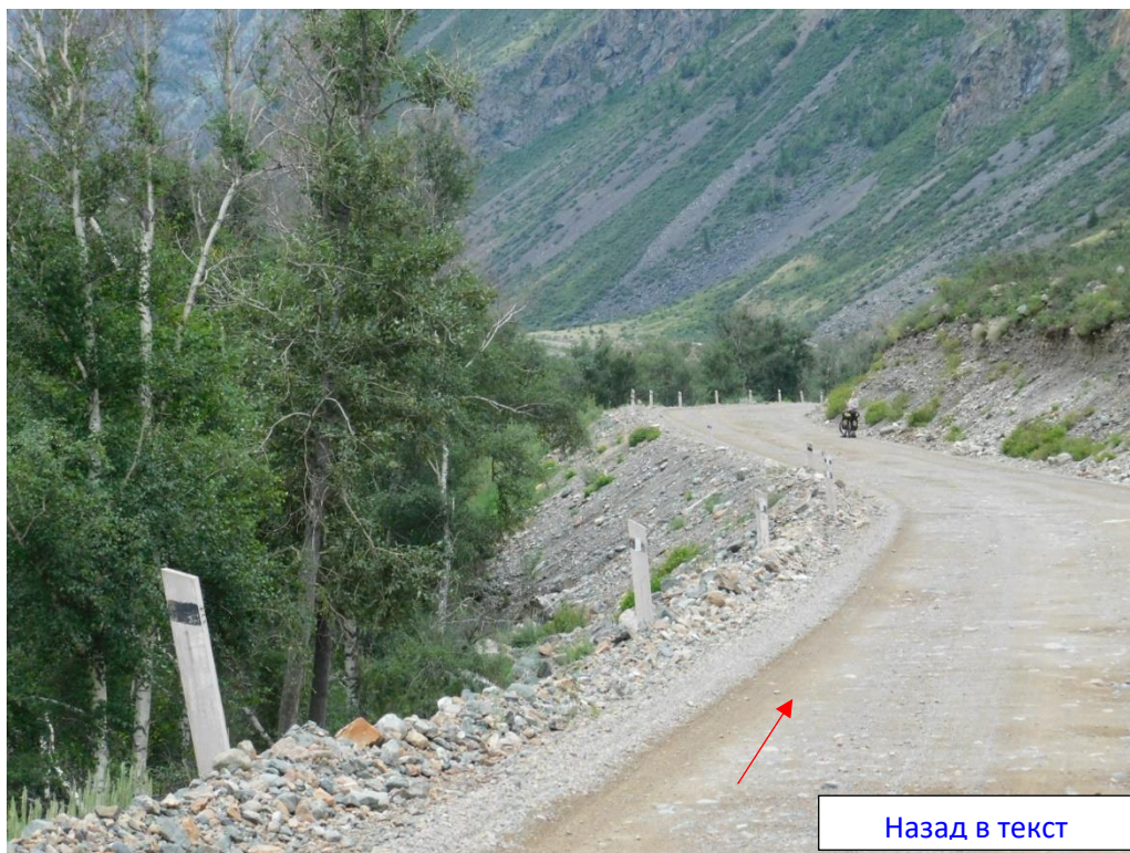
Фото 25. Движение по дороге на участке турбаза «Уту-Кайя»-перевал Катй-Ярык. Справа – осыпные склоны, слева-обрывистый берег р. Чулышман
