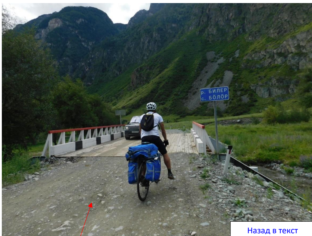
Фото 11. Мост через р. Билер
