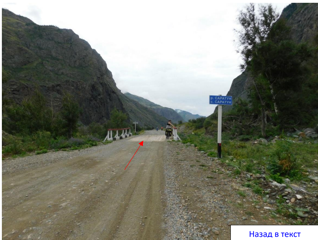
Фото 28. Проезд через мост через р. Саратун
