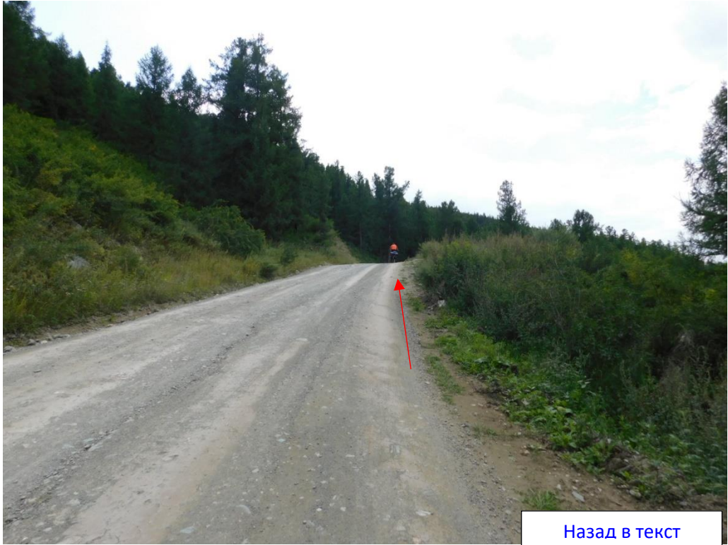
Фото 41. Движение на участке Кату-Ярык-Балыктуюль
