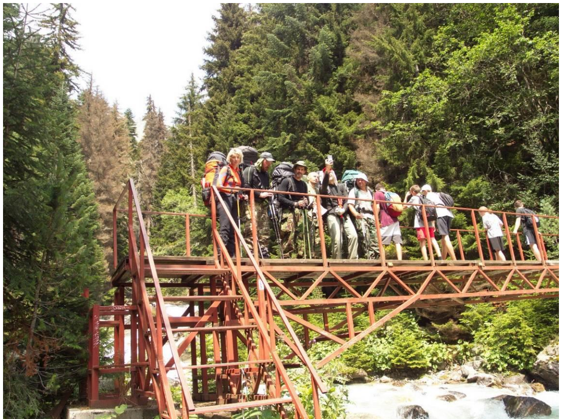
Ф.122 Мост через р.Хаджибей находящийся ниже слияния с р.Бадук.
