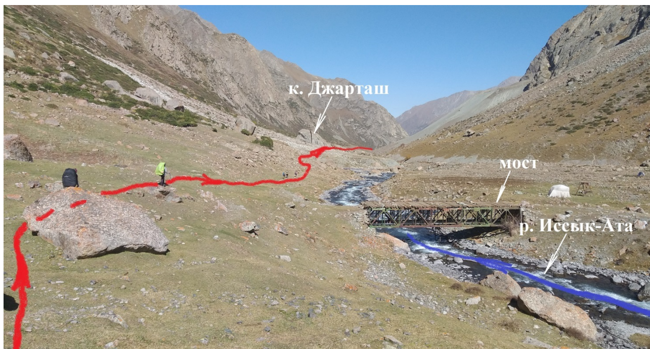
Фото 81. Мост через р. Иссык-Ата
